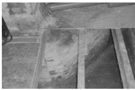
DP2: Annexe, chimney base looking W
