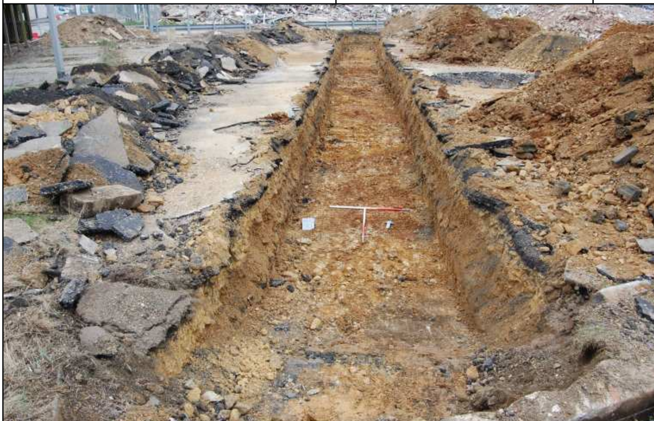
Plate E1: Trench E1, looking east
