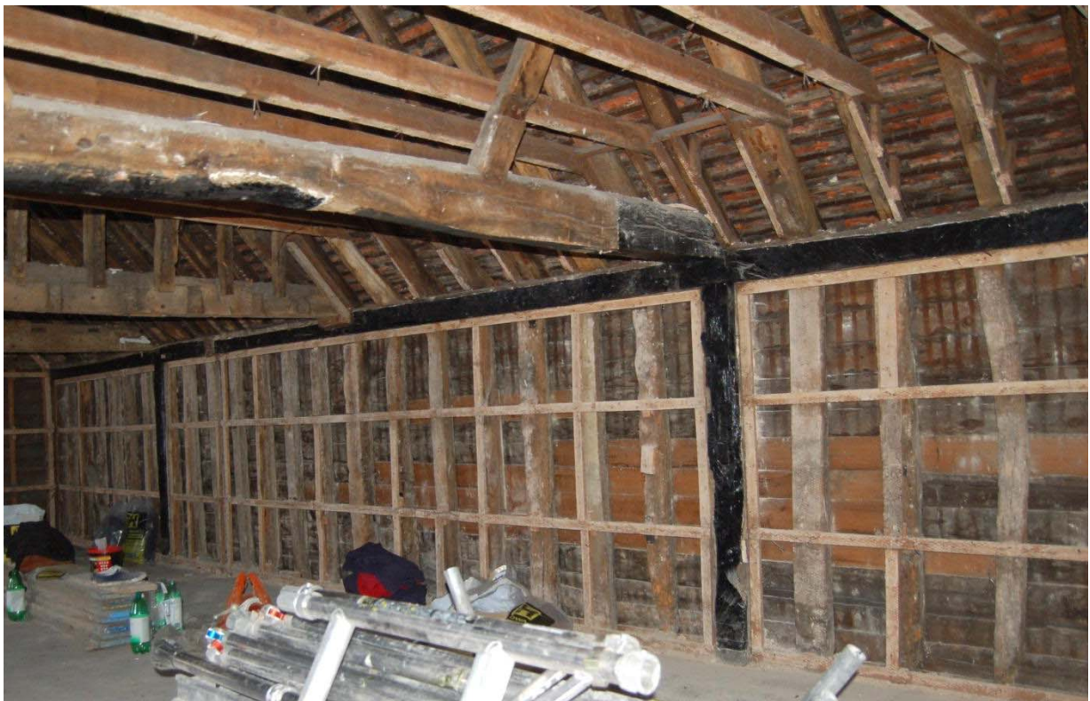
Plate 10 West wall of Room F1
