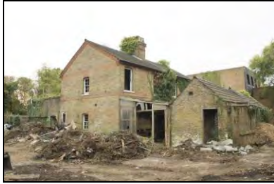
HRI17-0004 NE elevation of n.17. Facing south
