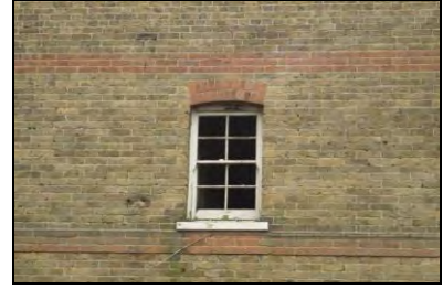
HRI17-0003 Detail of a window, NE elevation n.17. Facing south-west
