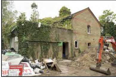
HRI17-0001 NE elevation of n.17. Facing north-west
