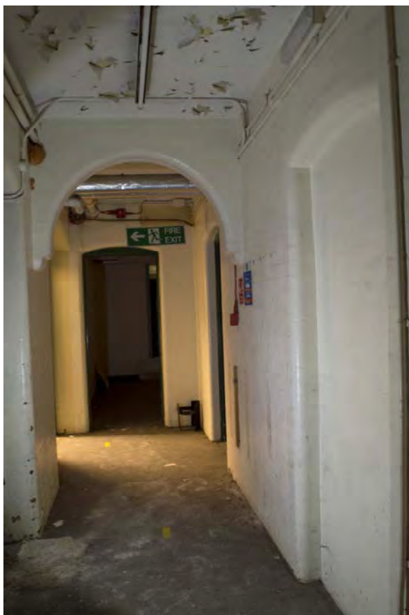
Plate 8: Blocked doorway in the basement (SJH18-0125)
