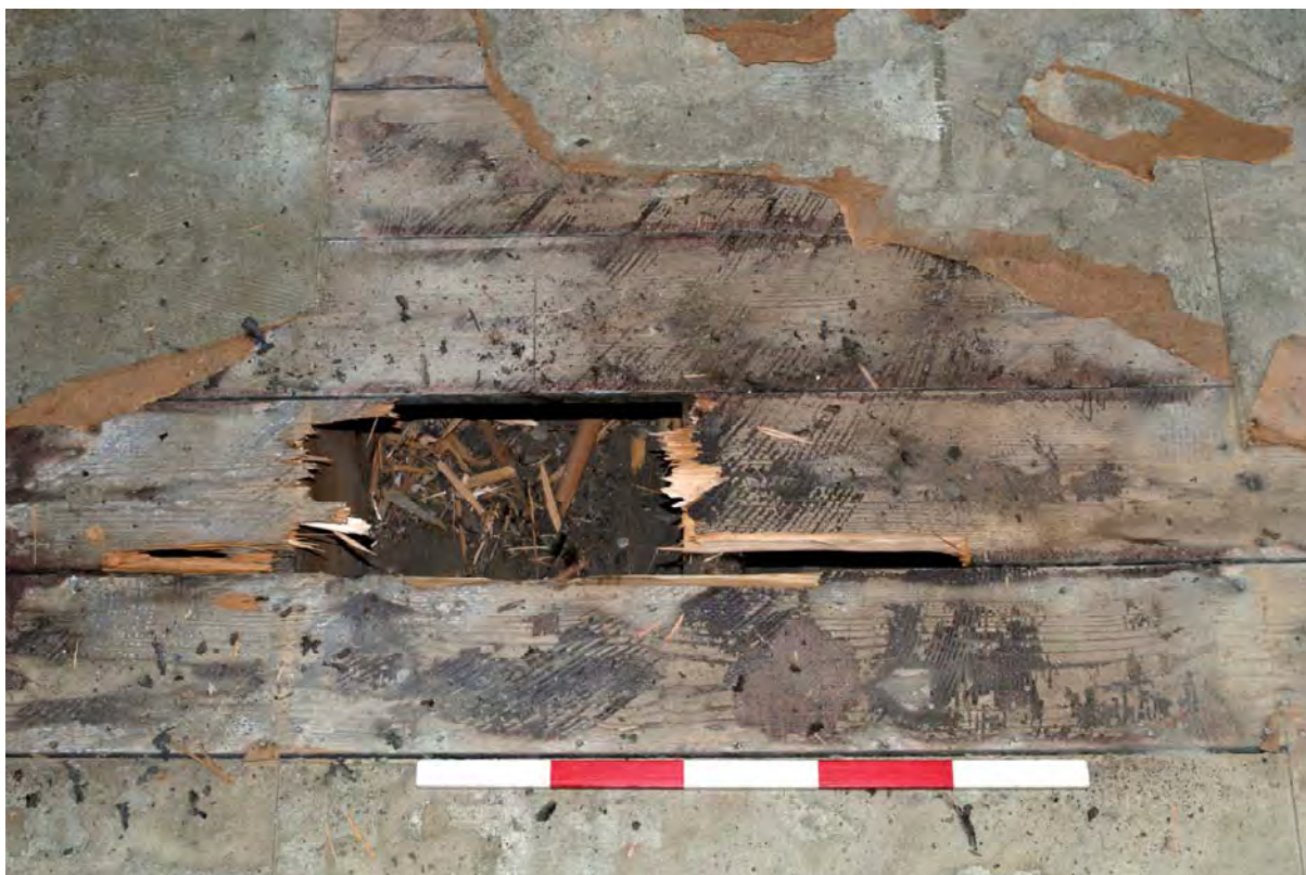
Plate 24: Original floorboards (SJH18-0115)
