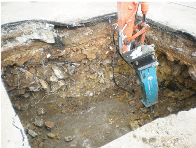
DP 23. Trench 6. View N.
