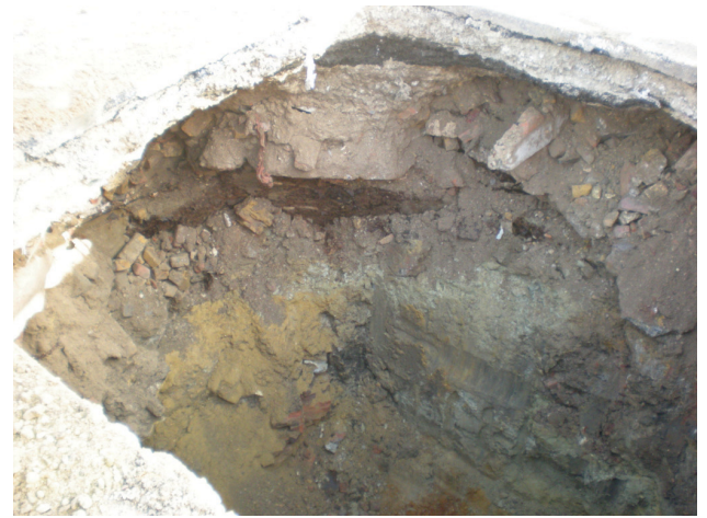
DP 10. Trench 1. View N.
