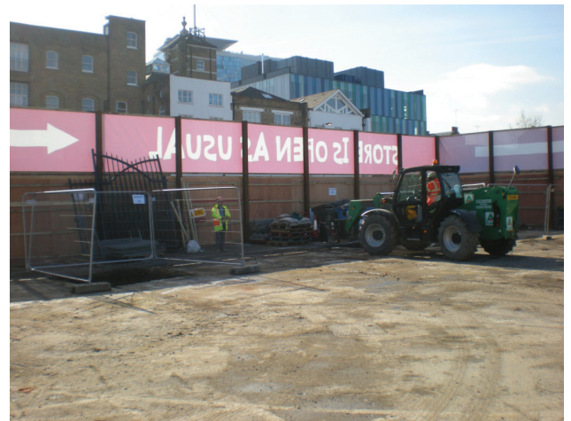
DP 4. Trench 2. View S.
