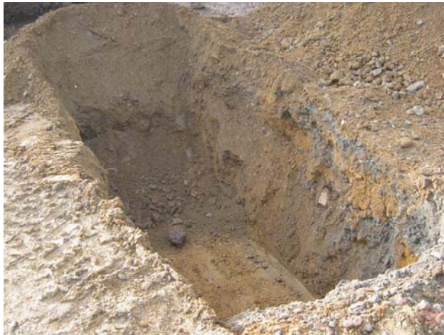
DP 15. Trench 3C. View N.
