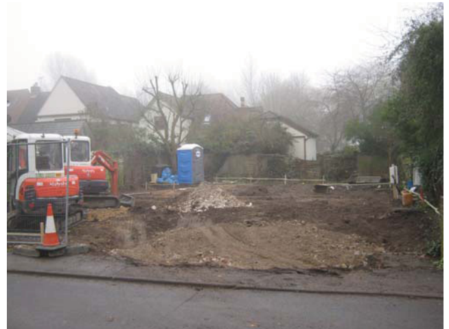
DP 2. The site. View S.
