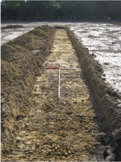
DP 31. Trench 21. View S.
