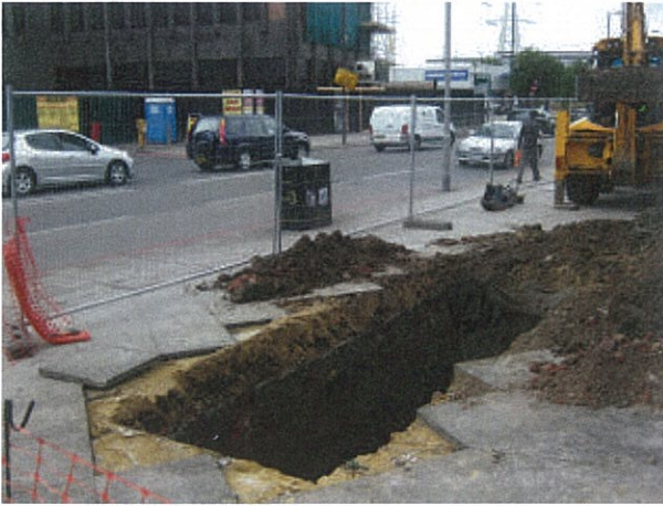
DP 1. Trench 1A. View S.
