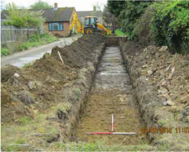
1 Trench 1. Looking ESE.
