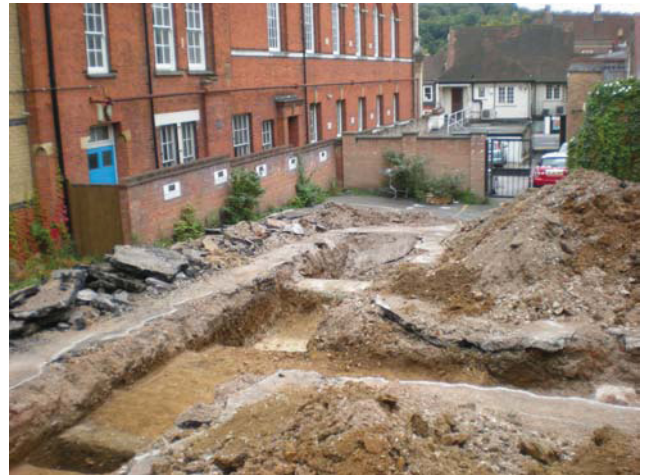
DP 2. The site. View S.
