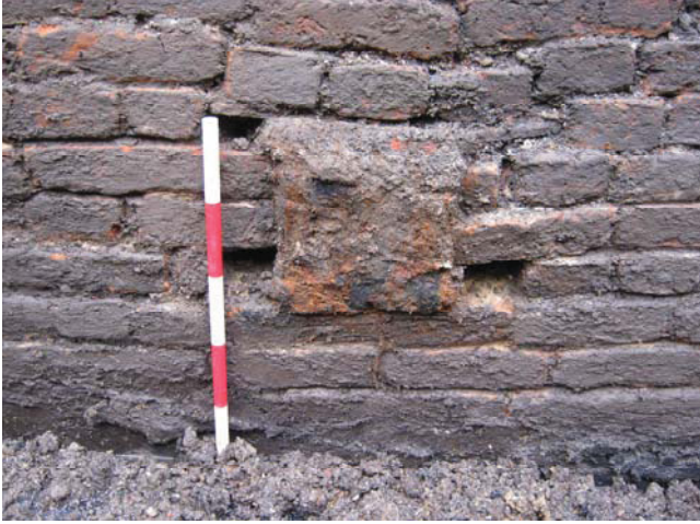
DP 13. M1007. View SE.
