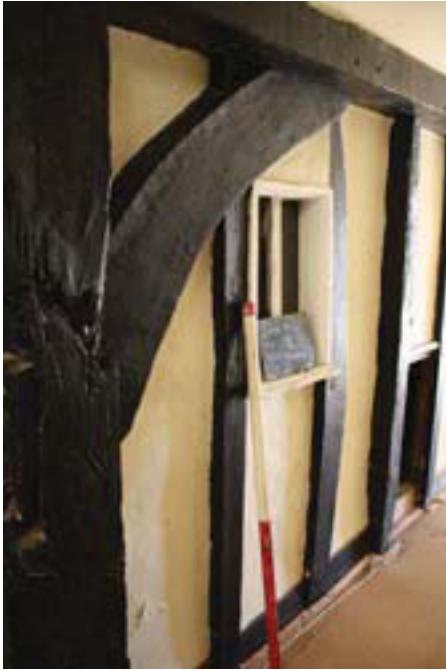
Plate 17. Interior, corridor window, Scale: 1m.
