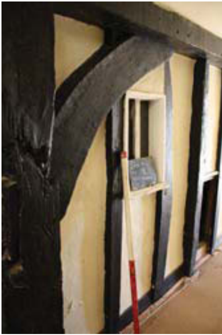
Plate 17. Interior, corridor window, Scale: 1m.
