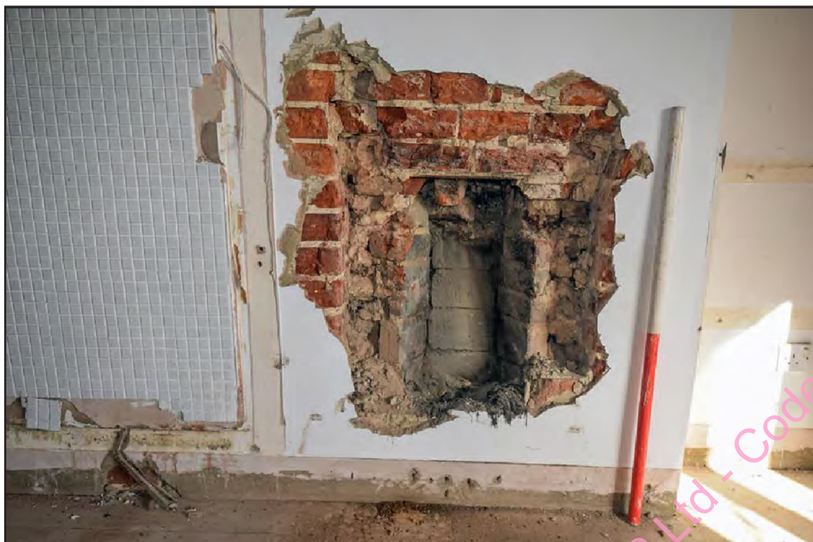
Photo A- 40: Bedroom F1 fireplace
