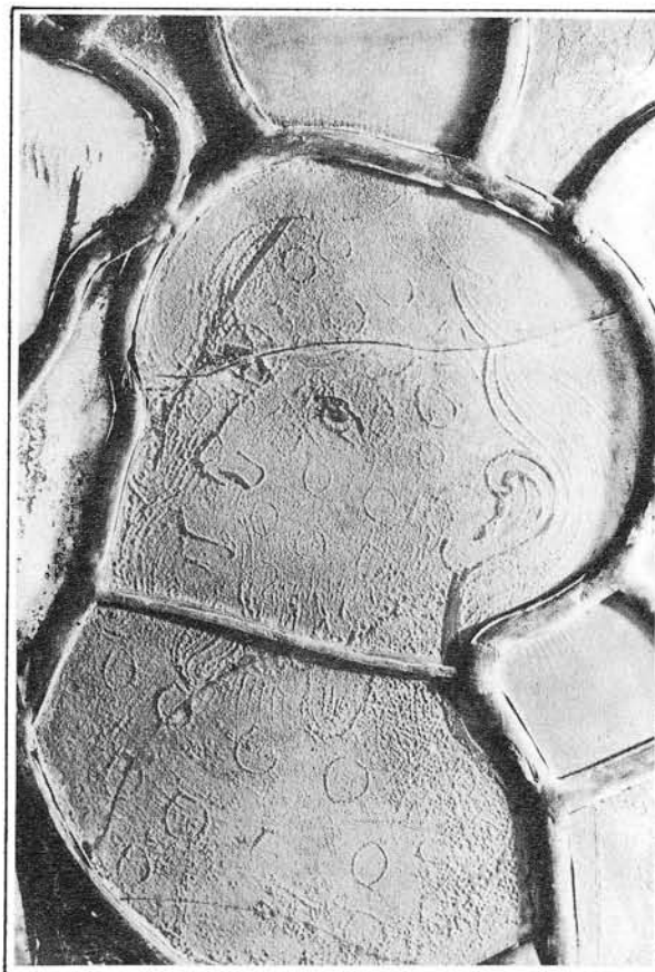
Abb. 12 Uelzen, Heiligen-Geist-Kapelle, Chors III, 3 b, Detail: Verwitterungsrelief im Seitenlicht (1980)
