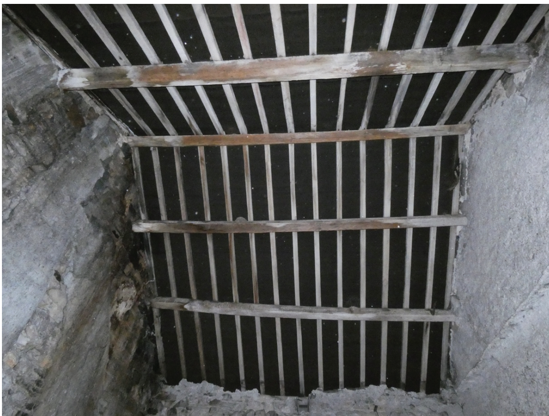
Plate 72: Roof above F1
