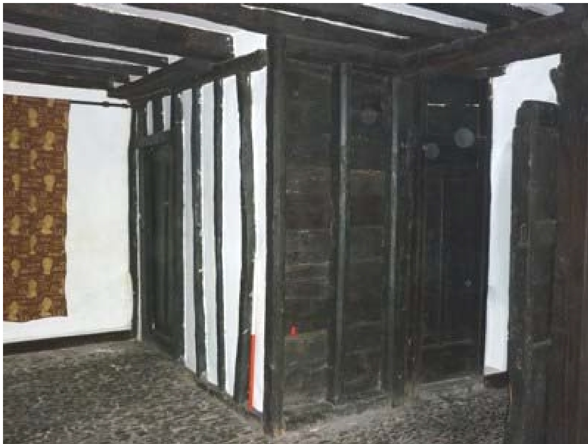
Plate 72: Internal stud walls
