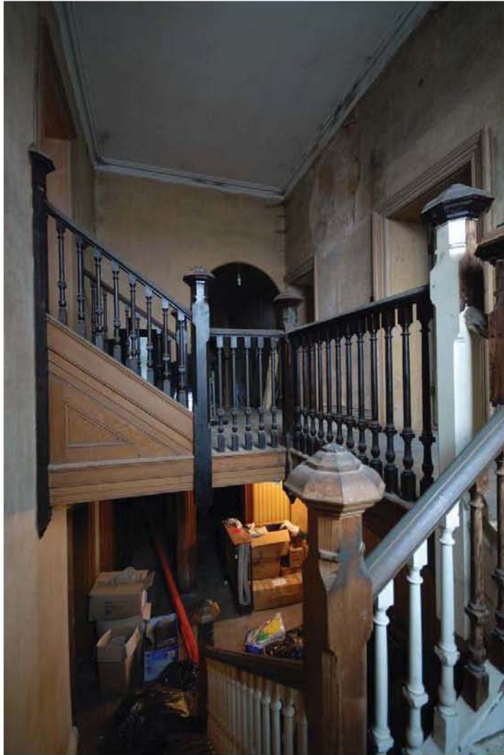
0042 The first floor landing F1 Fig 35
