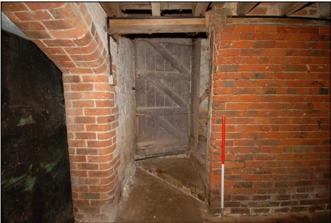
The stair door Fig 16
