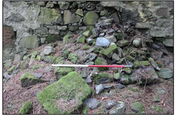
b: Pos. External stair, 1013
