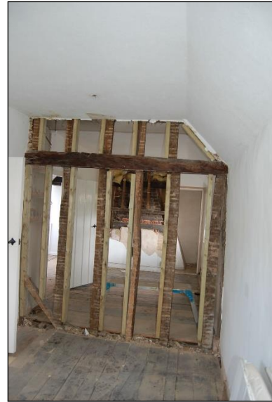
Plate 62: Room F4/F6 stud partition
