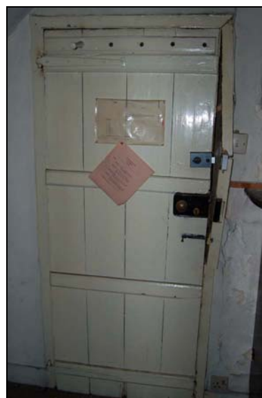
Plate 74: Room S2; door detail
