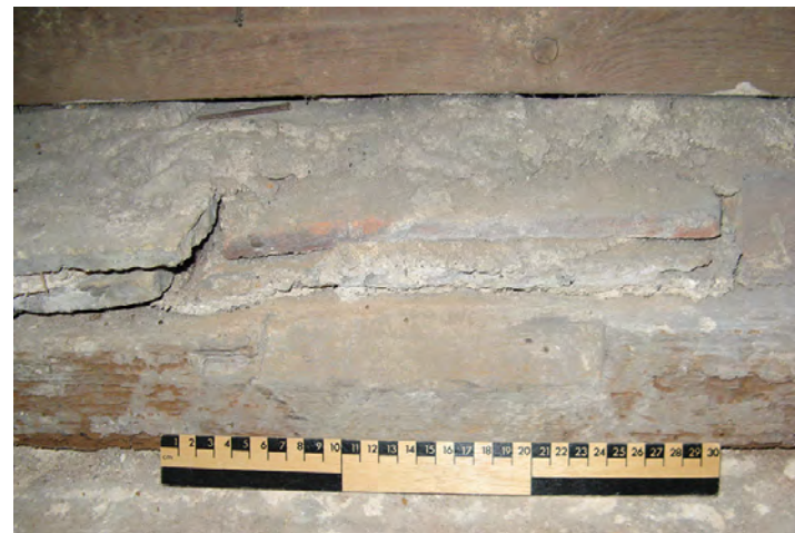
(d) Front notch in earlier outer wall plate
