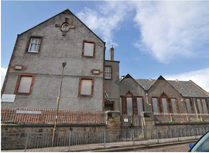
Plate 5 - SE facing elevation
