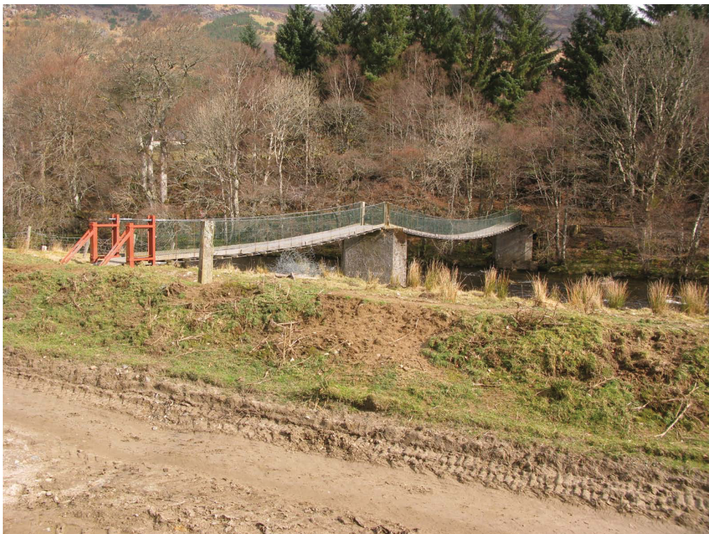
Fig. 5 - Site 16 from SE
