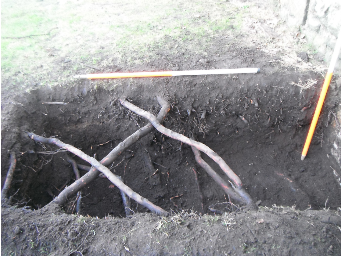
Fig. 4 - Pile Cap Trench 3
