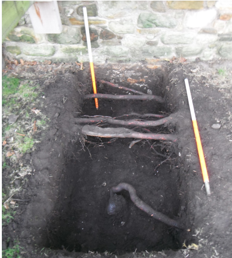
Fig. 2 - Pile Cap Trench 1
