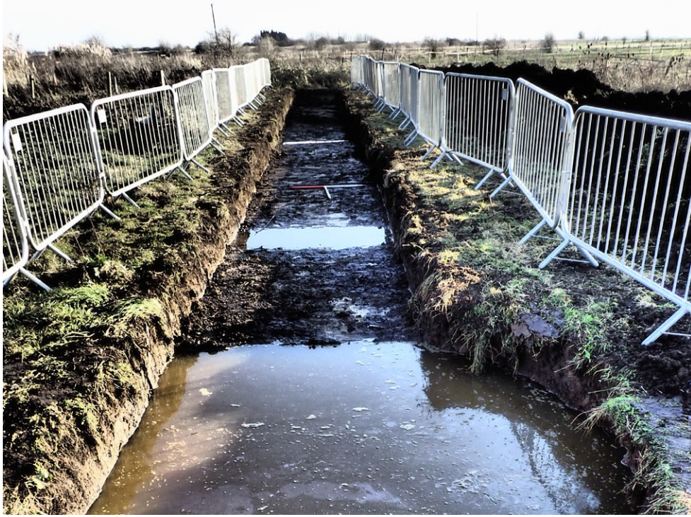
Fig. 18 - Trench 5, looking SE
