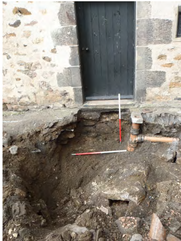
Fig. 6 - Stone culvert (159)
