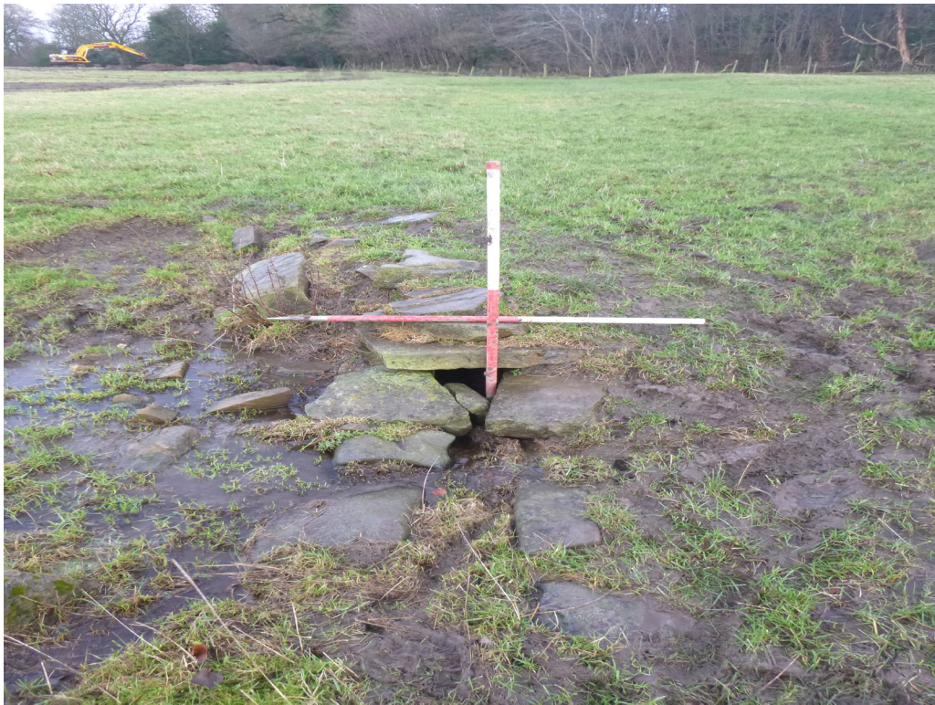
Fig. 8 - Box drain on edge of pond
