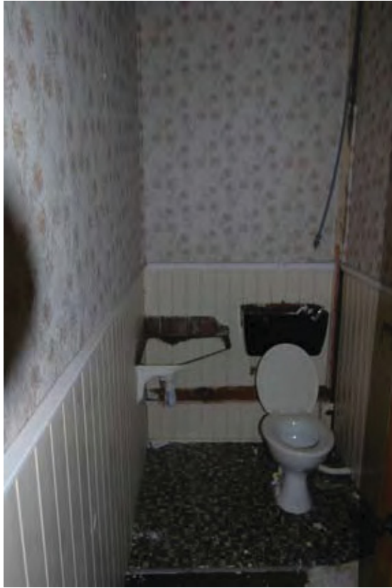
Fig 17. Interior: vestry toilet
