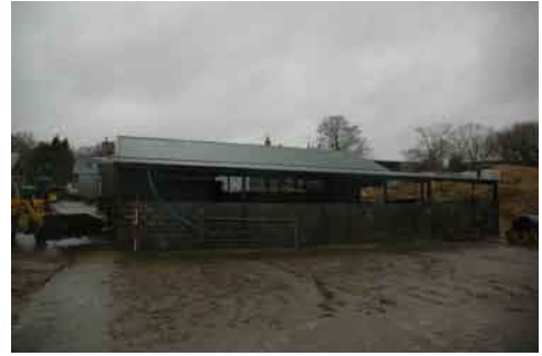
Shed 2, SE elevation
