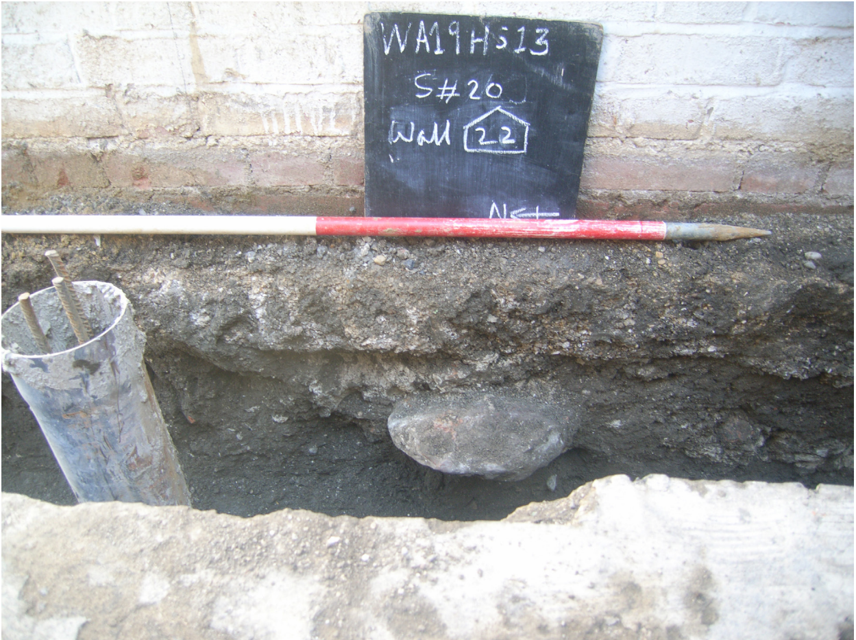
Plate 3: Wall 22 with mini pile
