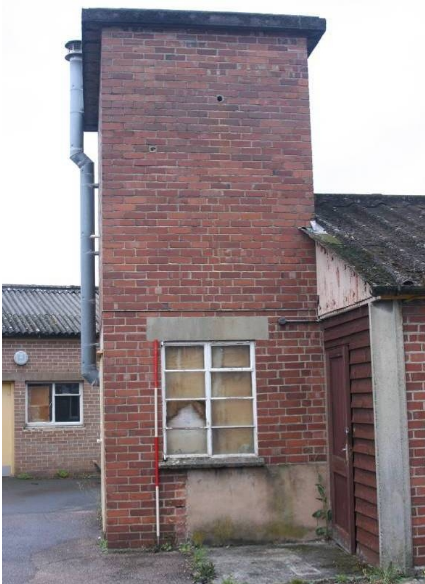
Plate 39. MOWP Hut (D) boiler chimney (scale 2m; from E)
