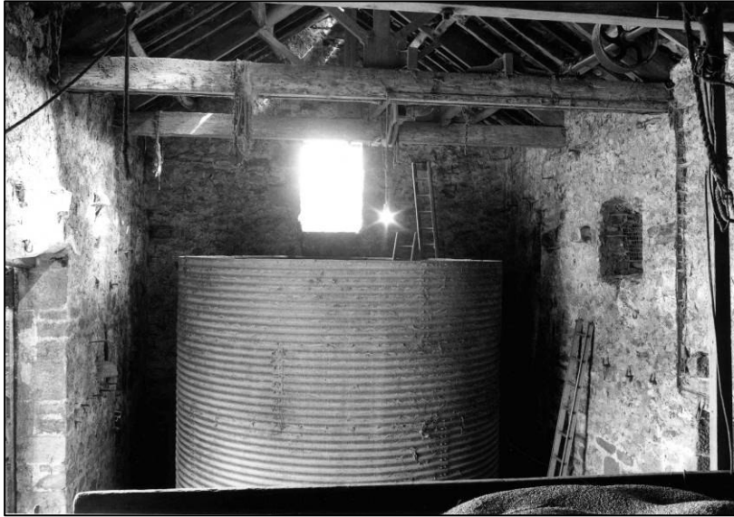
Plate 81: Barn: interior, looking W (photo 6/5).
