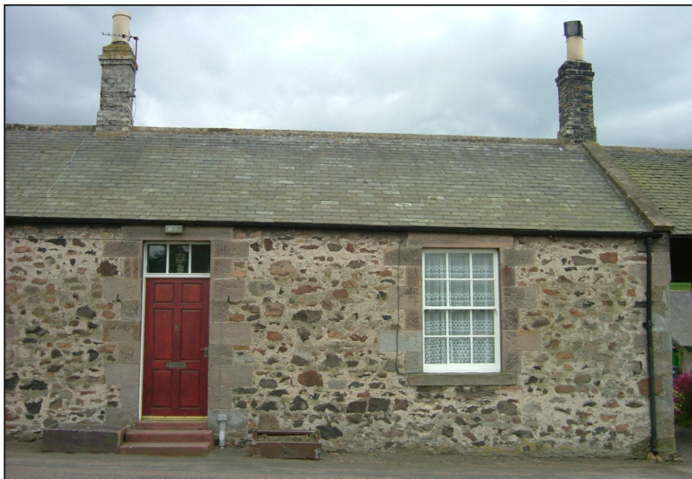
Fig. 31: Akeld Cottages, AK_MP 007
