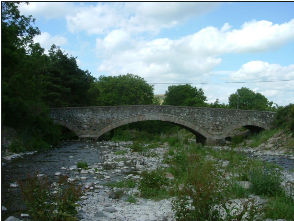
Fig. 83: Westnewton bridge (WN_MP 041)
