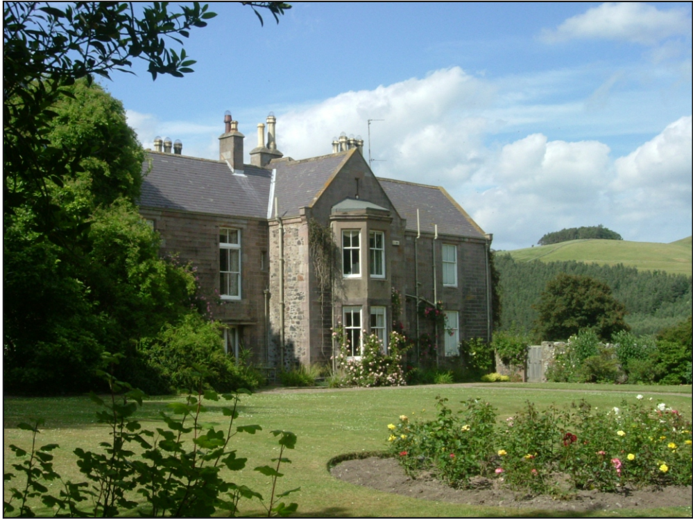
Fig. 82: West Newton House (WN_MP 030)
