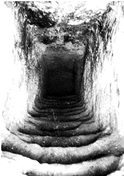
Fig. 6.11: Shaft 1, Nahal Snunit tunnel, Caesarea, Israel [Siegelmann 2002, fig. 14b].
