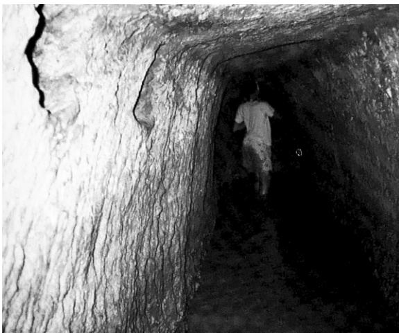
Fig. 6.8: Rock cut tunnel: En Ami tunnel, Caesarea, Israel [Siegelmann 2002, fig. 4a].
