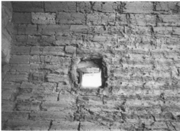
c) Nordwest-Zisterne, Gewölbe
