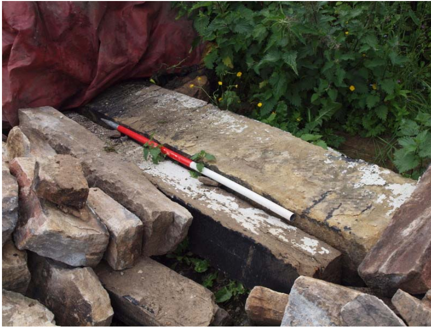
Plate 33: Sandstone door lintels
