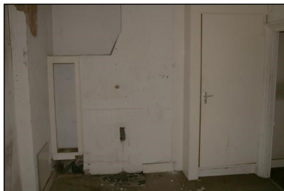
Plate 37: Chimney Breast East Wall E2
