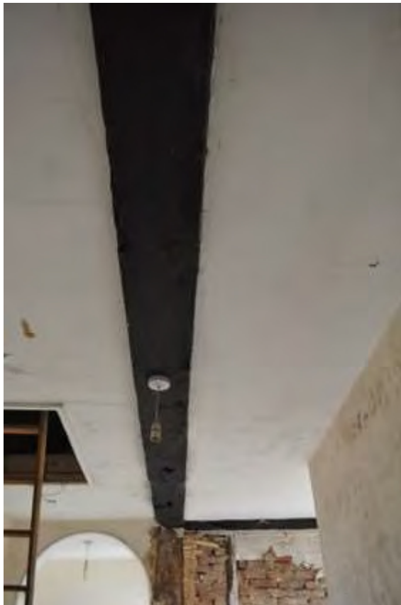
Plate 17: Ceiling timber F1
