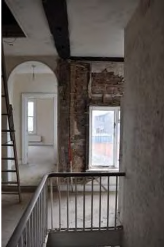
Plate 16: South wall F1
